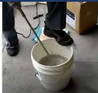
②主材(2.6kg)と混和液(1.3kg)を混練
